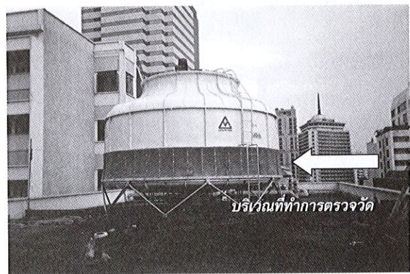
รูปที่ 10 การสุ่มวัดปริมาณลมที่บริเวณ Inlet Louver
